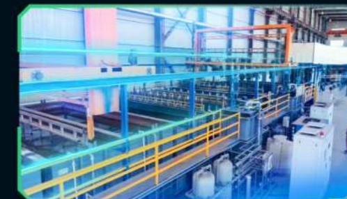
电泳涂装生产线
